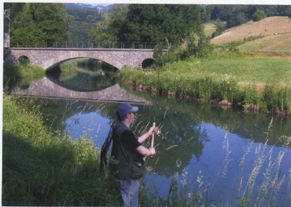
Der Schweizer Rheintalinnenkanal soll oberhalb der Bahnbrücke bei Rüthi naturnah und breit ausgebaut werden.
